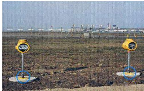
Figura G2-4. Ejemplos de Cuplas Frangibles montaje de tubos en luces de aproximación
