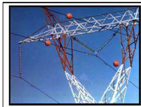
**Figura H4.2. Señalamiento de líneas de tensión con esferas de un solo**
