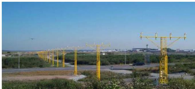
Figura G2.2 Torres de iluminación de aproximación — Estructuras reticulares de fibra de vidrio
