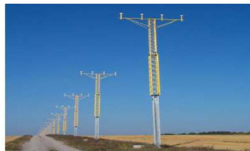
Figura G2.8. Torres de iluminación de aproximación de fibra de vidrio sobre estructuras de soporte rígidas
