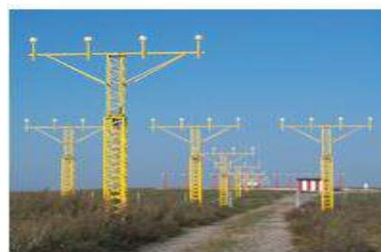
Figura G2.9. Torres de iluminación de aproximación de fibra de vidrio
